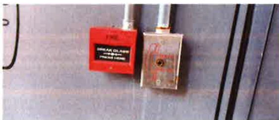
รูปที่ 2-8 อุปกรณ์แจ้งเหตุด้วยมือ และชุดเต้าเสียบโทรศัพท์
