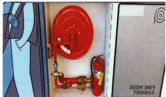
รูปที่ 2-13 ตู้เก็บอุปกรณ์ดับเพลิง
