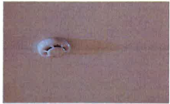
รูปที่ 2-11 เครื่องดับก๊อควัน
