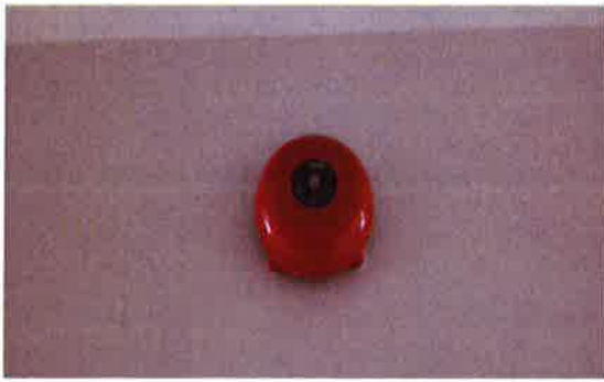
รูปที่ 2-10 กริ่งแจ้งเตือนเหตุฉุกเฉิน
