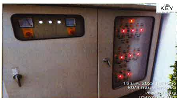
รูปที่ 2-37 ตู้ควบคุมของระบบบำบัดน้ำเสีย
